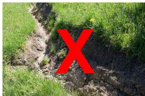
Der maschinelle Unterhalt führt häufig zu übertriebenen Grabenbreiten. Im Beispiel rechts wurde der Graben zu breit ausgehoben. Zudem wurde das Material unsachgemäss in die Schutzfläche verstrichen. Häufig werden zu breite Löffelschaufeln verwendet. Der ursprüngliche Graben wurde um das Dreifache verbreitert.
