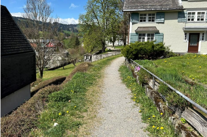
Abbildung 2 Km 50, Blickrichtung Nordwesten
