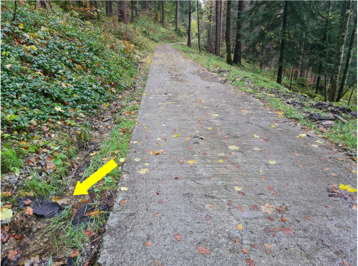
Abb. 6: Oberflächenabfluss im bergseitigen Strassengraben
