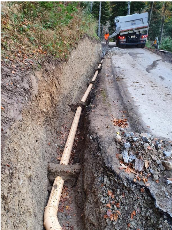
Abb. 7: Bergseitige Sickerleitung
