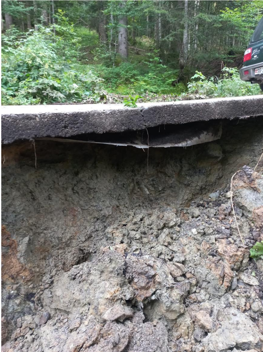
Abb. 14: Talseitige Rutschung
